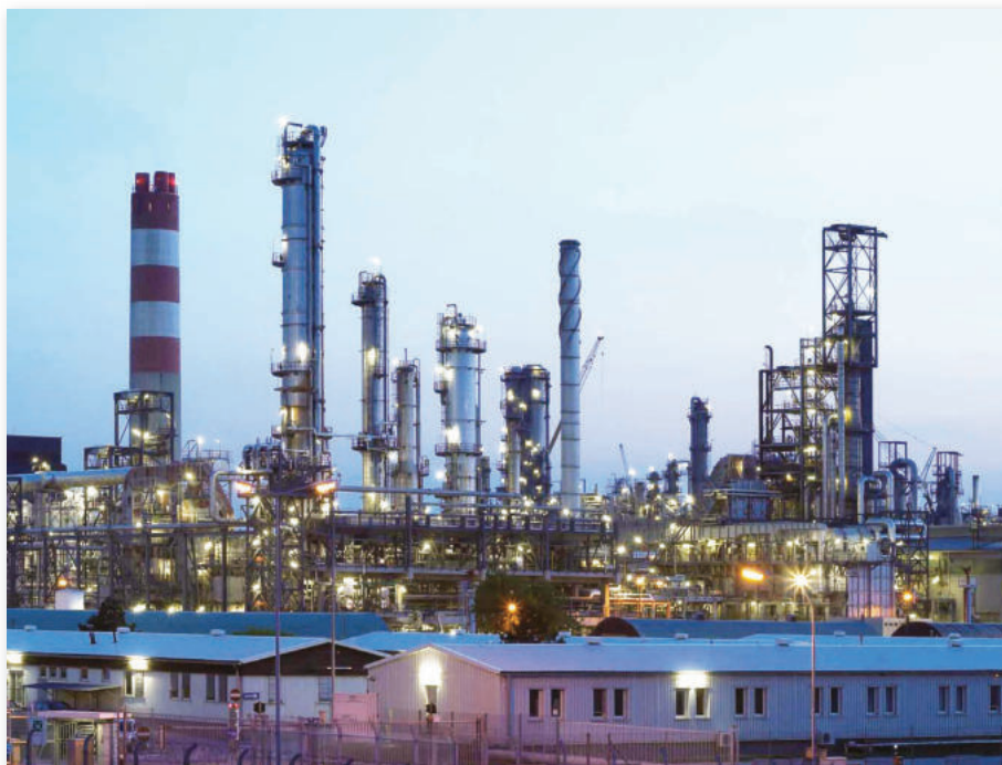
● إحدى مصافي النفط الكويتية
